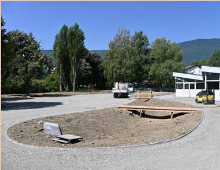
Les travaux fin juillet.
