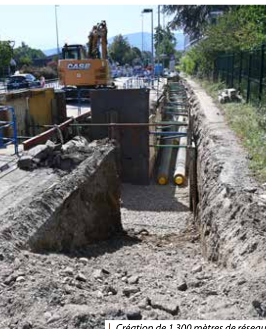
Création de 1 300 mètres de réseau
