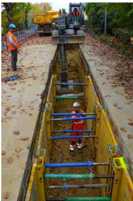
Tranchée : 2,2 mètres de profondeur et 1,4 mètres en largeur – En novembre, avenue Jean Moulin.
