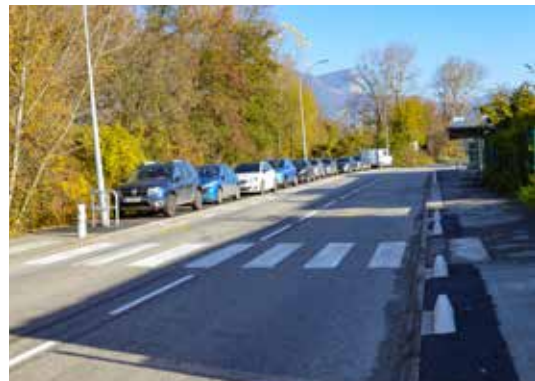
Les travaux se sont déroulés cet automne rue Denis Papin pour laisser place à un espace plus sécurisé entre les trottoirs et la chaussée.
