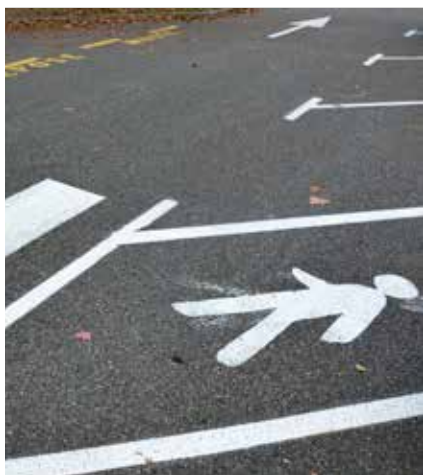
Parking du bâtiment de la maison de la musique Vladimir Cosma.
