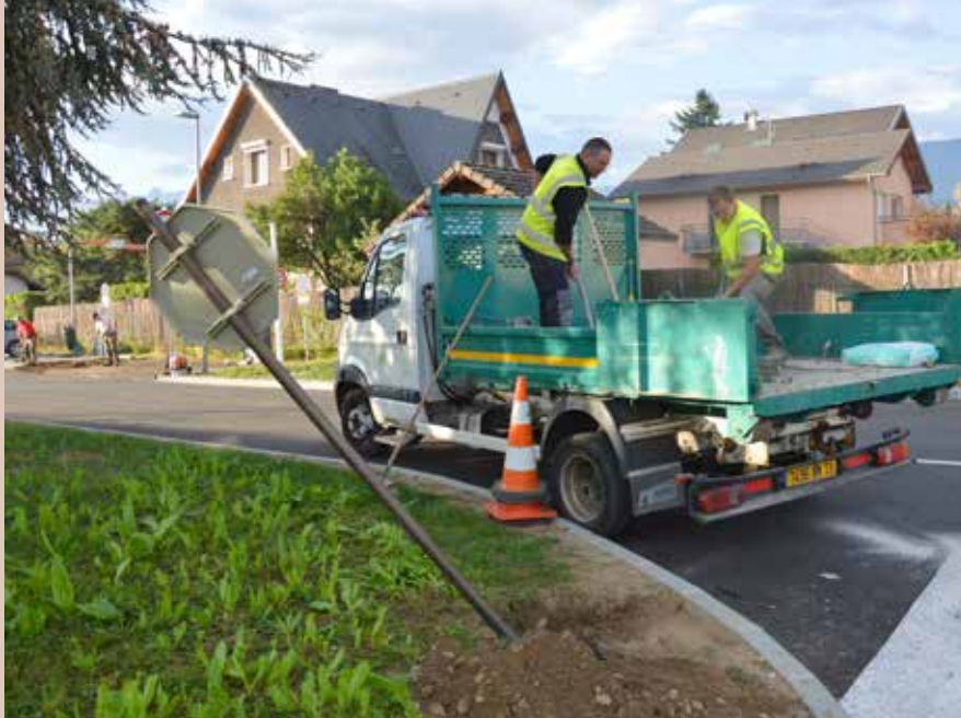
Remise en service du panneau de signalisation routière à l'entrée du parking de la plaine sportive Raoul Villot par le personnel du service voirie – Mercredi 18 octobre.
