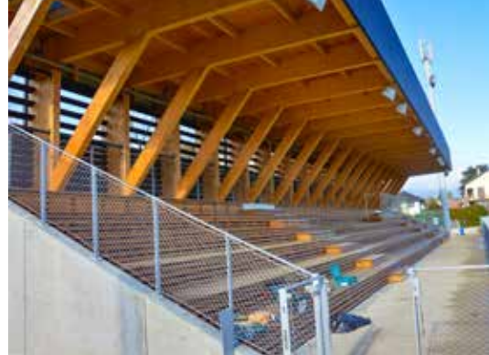
Quelques finitions sur l'ensemble en structure bois et métal – Mercredi 29 novembre
