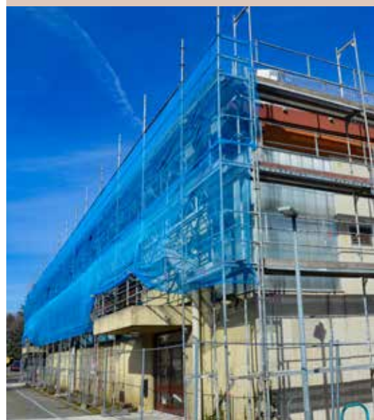
Vue du bâtiment fin février.
